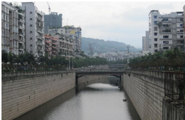
自然溪河、湖库、明渠
