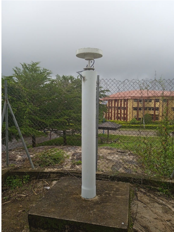
CORS Antenna Monument
